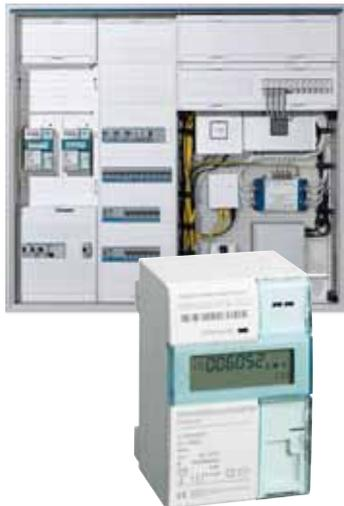
*Entweder über das eingebaute Display oder auch am PC: Durch die neuen »elektronischen Haushaltszähler« kann man seinen Stromverbrauch genau und schnell analysieren. Aber nicht nur das: Auch die Kontrolle des selbst erzeugten Stroms ist möglich. Im Hintergrund ein moderner Verteiler, in dem zum Beispiel auch der Router für den Internet-Anschluss Platz findet.*
